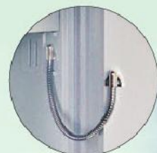
EMA-Vorbereitung EMA preparation
